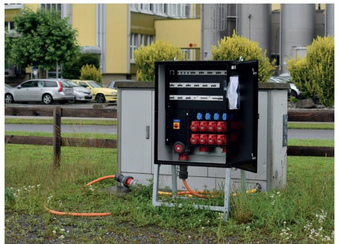
Si des distributeur d'énergie sont régulièrement utilisés à de nouveaux évènements ou manifestations sur différents sites, il peut être utile de mettre en place un système d'alimentation avec des conducteurs individuels enfichables. Avec le connecteur GIFAS PowerSAFE, il est possible d'éviter les raccordements pénibles de câbles lourds à section épaisse, pour une tension allant jusqu'à 400 A.
