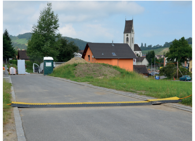
Pont de câble
