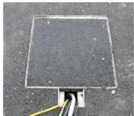
Toleranz Oberkante Befüllung +0/-1mm
