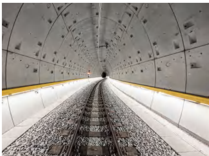
LaneLED GFK, tunnel Glatscheras
