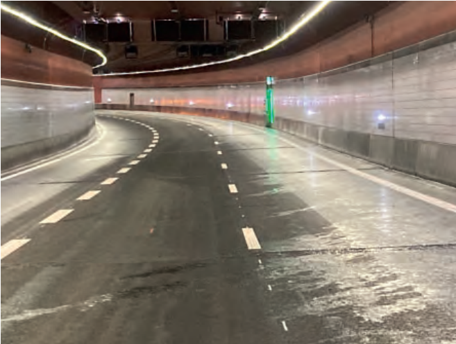
Mariefholmstunnel Göteborg Schweden
