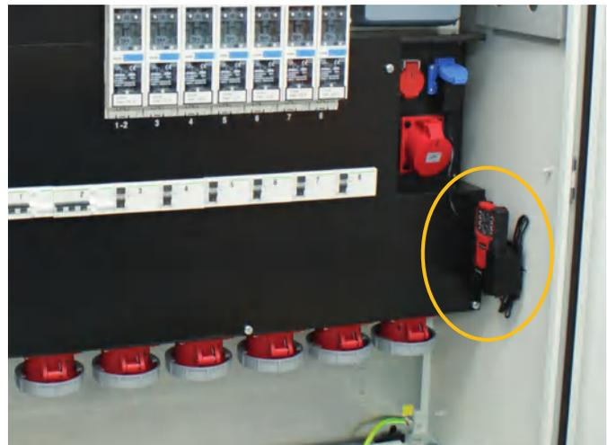
TorchLED Taschenlampe Notlicht in Baustromverteiler
