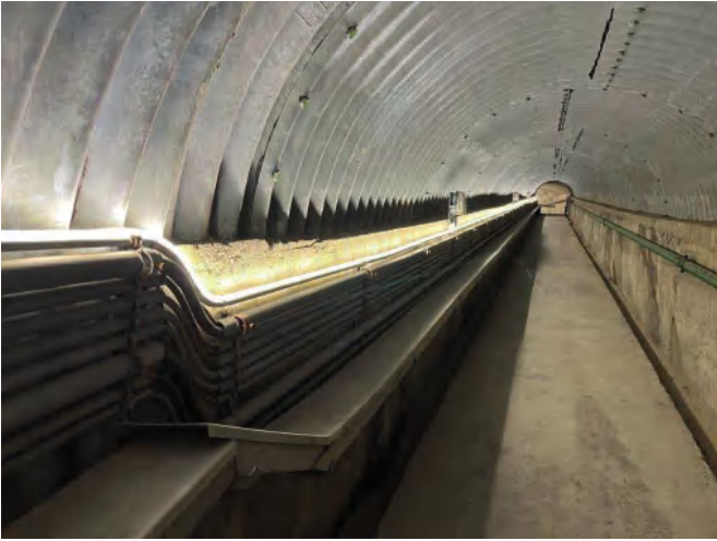
Muro della diga Grande-Dixence
