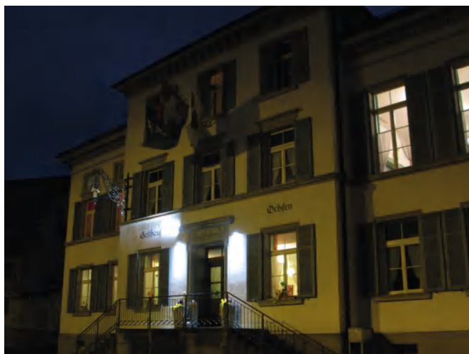
SpotLED 230V illuminazione di facciate
