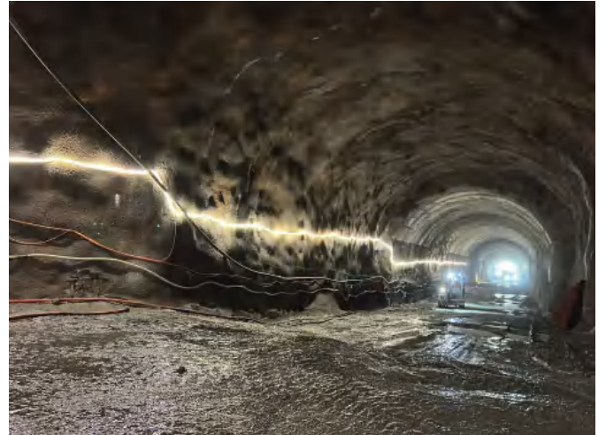
Implenia Suisse, ARGE Gotthard
