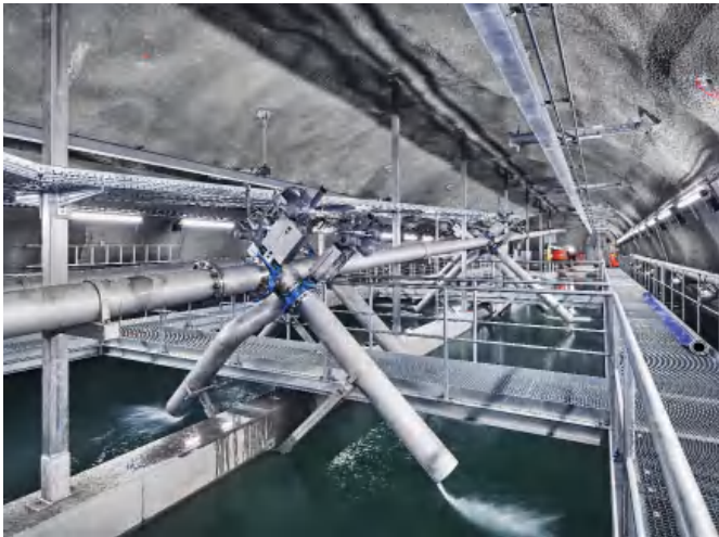
StreamLED 2: Client / Électricien: BLS Netz AG EPRO TRAFFIC GmbH: Planificateur spécialisé
