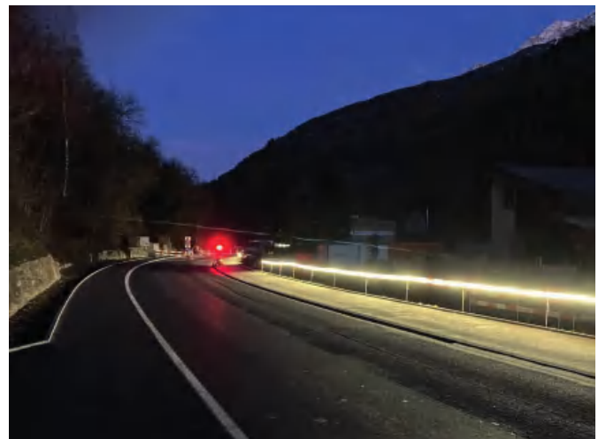
Chantier de Bitsch VS
