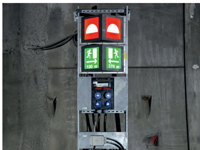
Uscita di sicurezza
