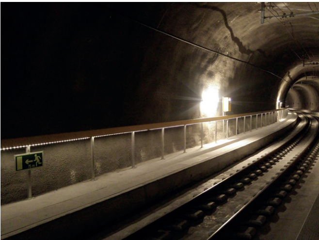
Installation du tunnel de Ruckhalde Appenzeller Bahnen
