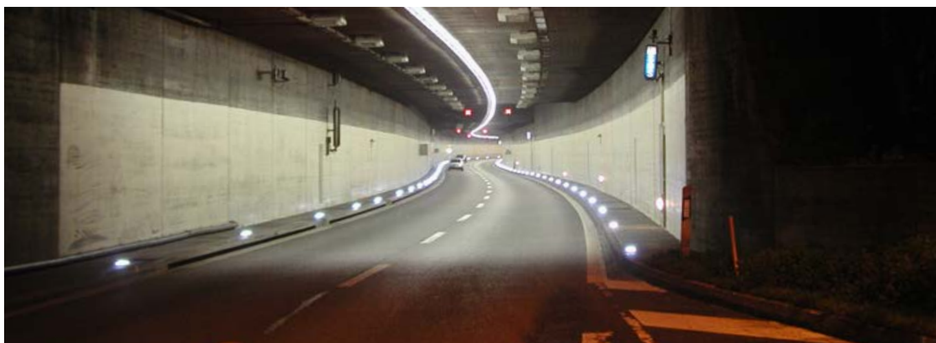
Systèmes de guidage LED dans le parking de la Haute Ecole FHS de Saint-Gall.
